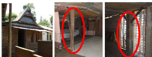
Gambar 6. Peralihan rumah panggung menjadi rumah bukan panggung, terlihat pada kolom kayu rumah panggung akan diganti menjadi kolom praktis rumah batu dan kolom rumah panggung masih terdapat dibagian jendela rumah. (Sumber: hasil survey, 2016)
