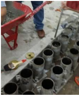
Gambar 3. Campuran beton dirojok di dalam silinder
