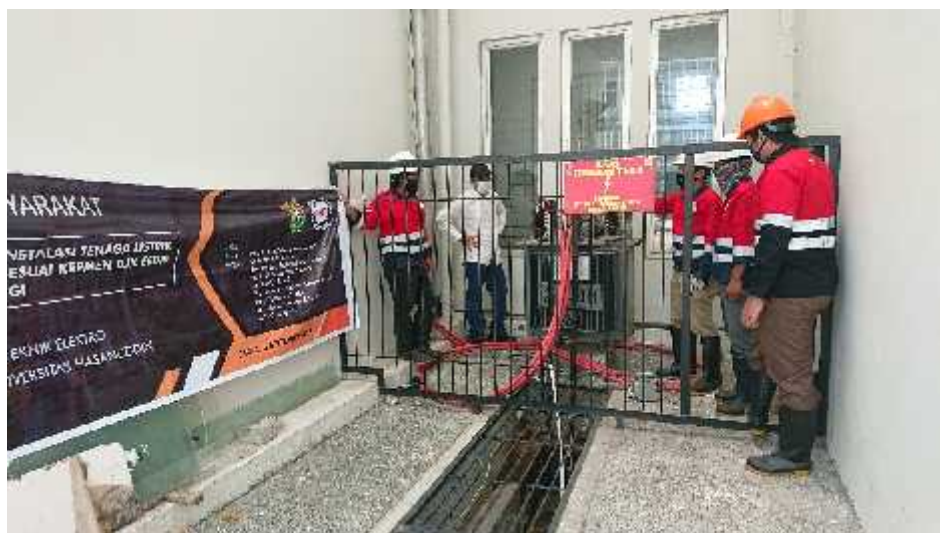
(c) Pelatihan Teknik Pemeriksaan Instalasi Pemanfaatan Tenaga Listrik
