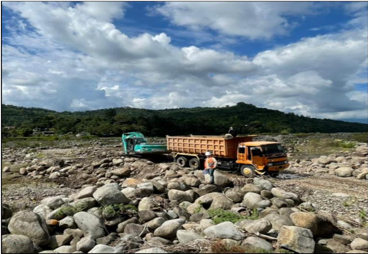
Gambar 2. Proses Penggalian Menggunakan Alat Gali Muat Kobelco SK- 200.
