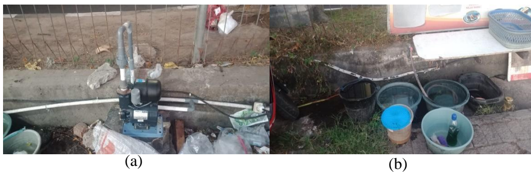
Gambar 3. (a) Sumur Bor sebagai Sumber Air Bersih PKL dan (b) Salah Satu Titik Pengambilan Air Bersih.
