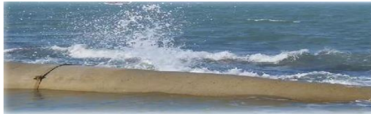
Gambar 2. Sabuk Pantai (APO) dengan Teknologi Karung Geotekstil Memanjang (KGM).
