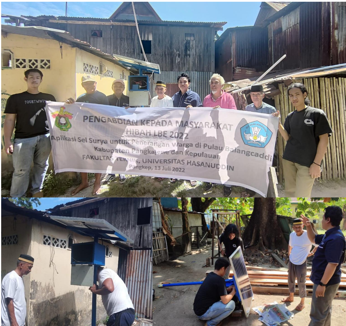
Gambar 5. Pemasangan Sel Surya untuk Penerangan Warga di Pulau Balang Caddi
