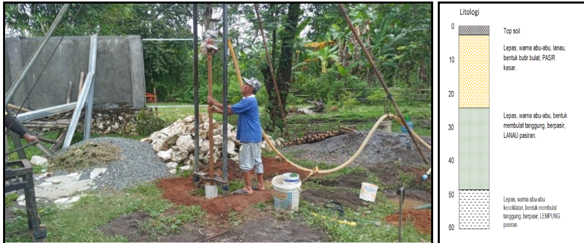
Gambar 5. Kegiatan Pengeboran Air Tanah Hingga Kedalaman 50 Meter
