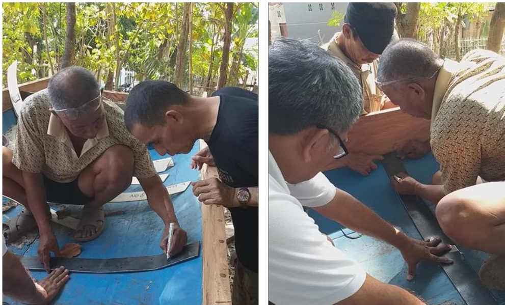
Gambar 2. Peragaan Pemasangan/Penyambungan Papan Kulit ke Rangka Baja
