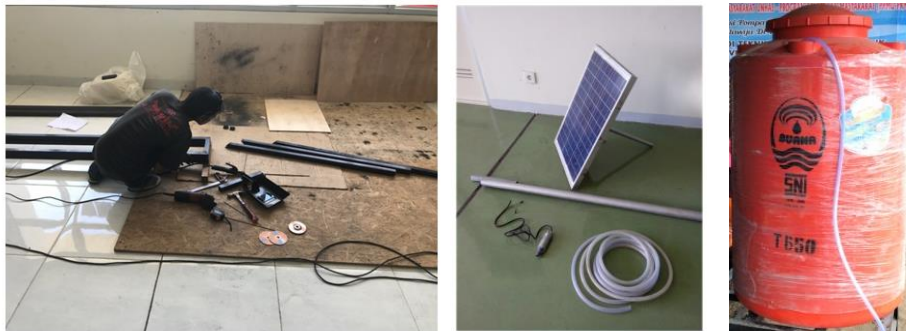
Gambar 3. Rancang Bangun Pompa Air Tenaga Matahari
