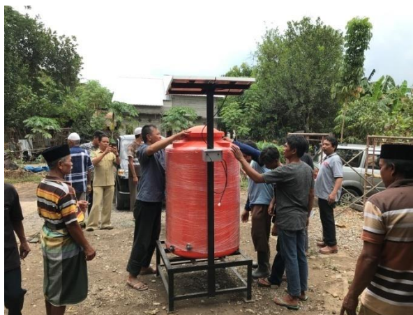
Gambar 5. Perakitan Pompa Air Tenaga Matahari
