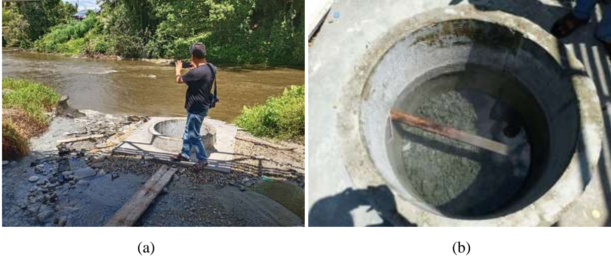
Gambar 6. (a) Sungai Baliase, sebagai Sumber Air Pendingin untuk Sistem ORC; (b) Sumur Sumber Air Panas untuk Sistem ORC
