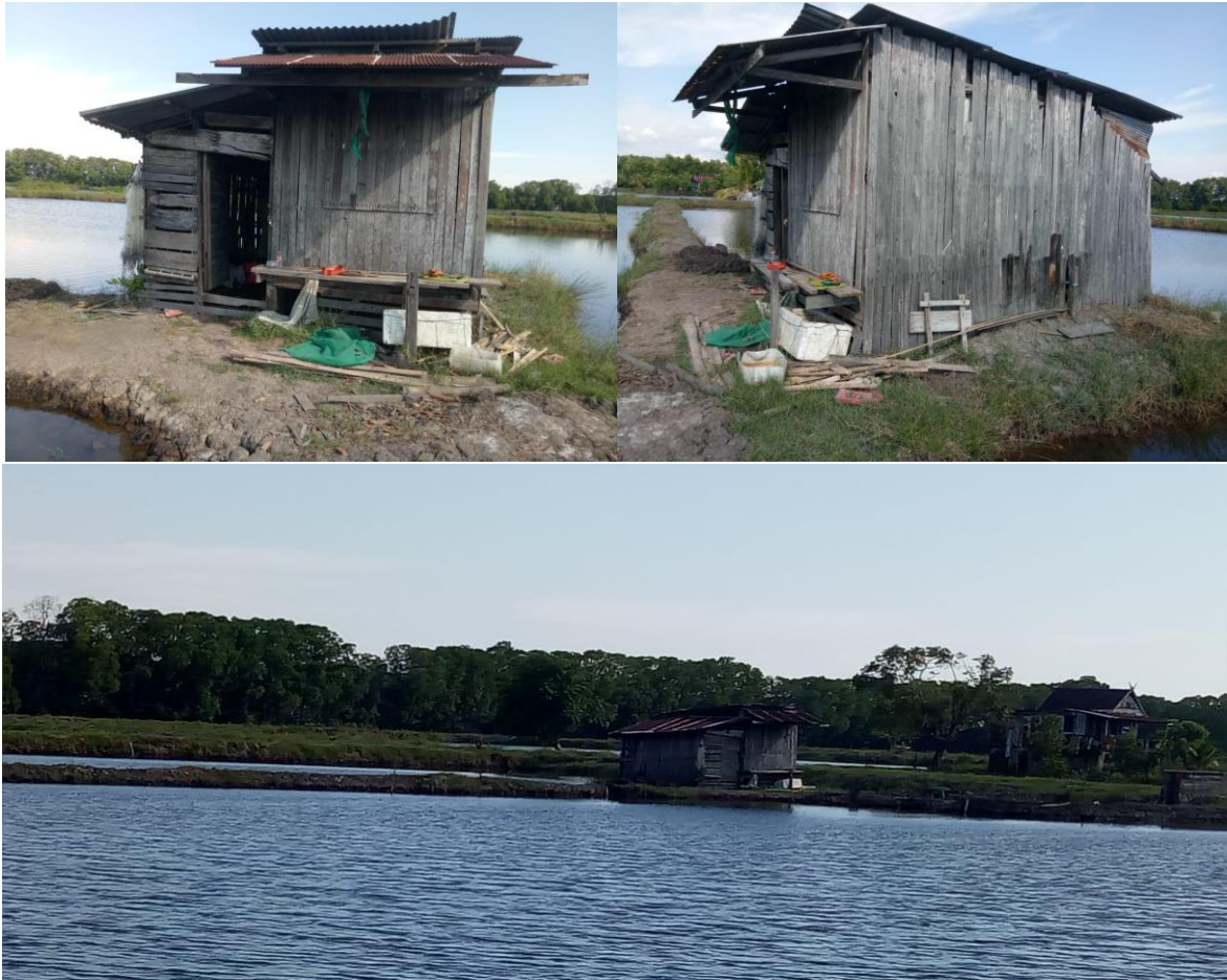
Gambar 1. Kondisi Rumah Tambak yang Tidak Memiliki Penerangan di Kampung Turungan
