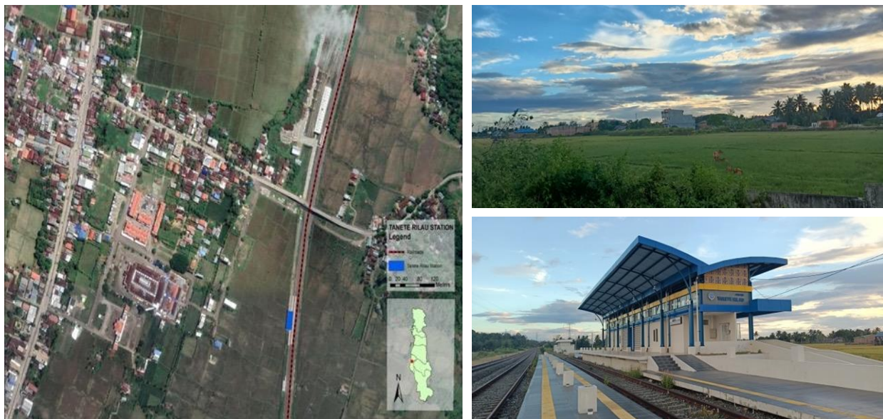
Gambar 2. Survei Eksisting Stasiun Kereta Api Tanete Rilau dan Sekitarnya
