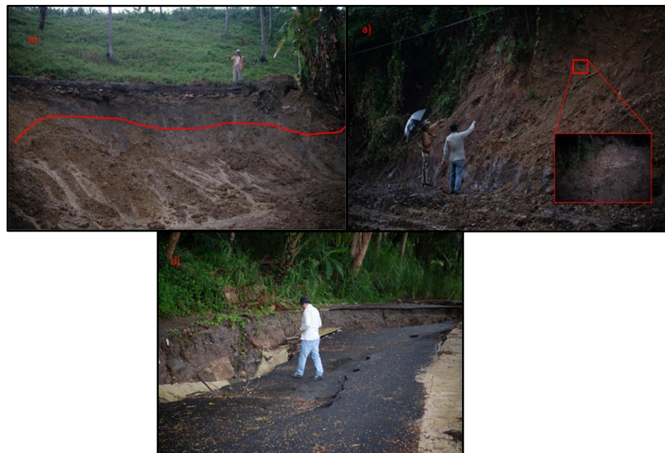
Gambar 3. (a) Longsor pada Daerah Tanuntung; (b) Longsor pada Daerah Lahola; (c) Amblas badan jalan pada Daerah Alarang
