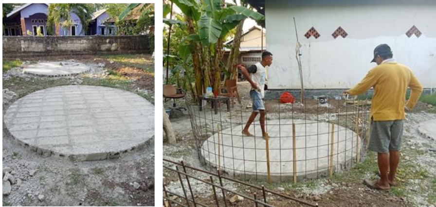
Gambar 3. Pemasangan Rangka Pendukung
