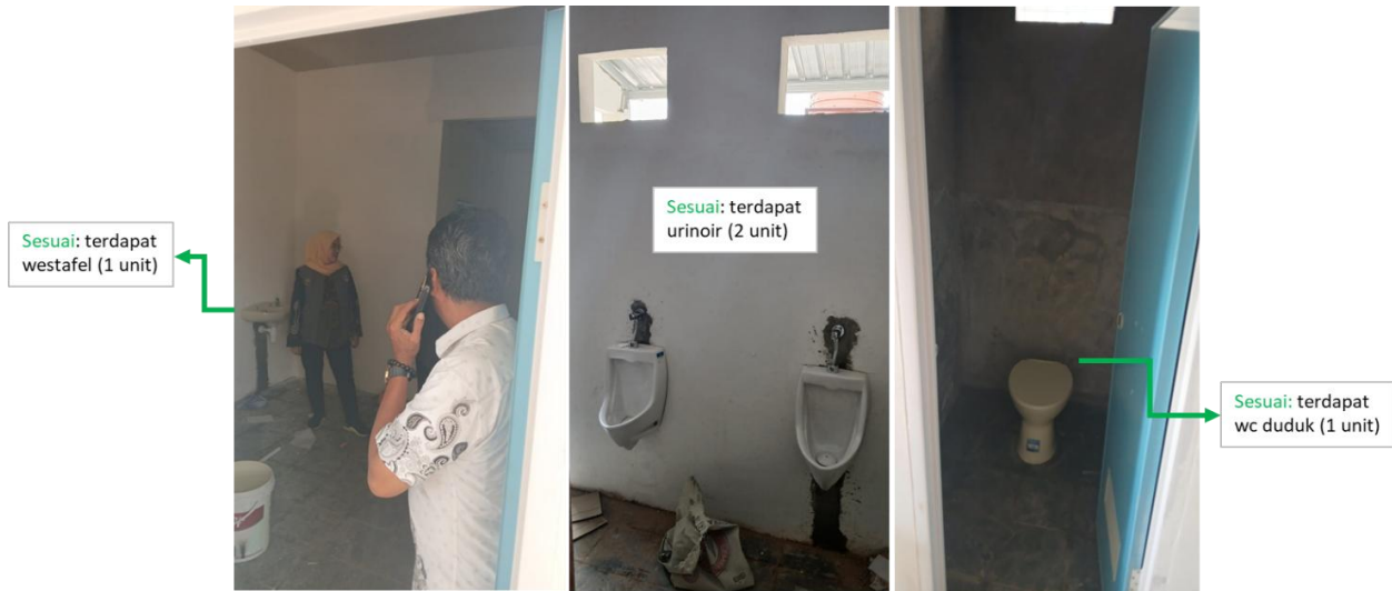
Gambar 7. Kondisi Fasilitas Toilet SMAN 10 Gowa Setelah Penyesuaian Sesuai Juknis
