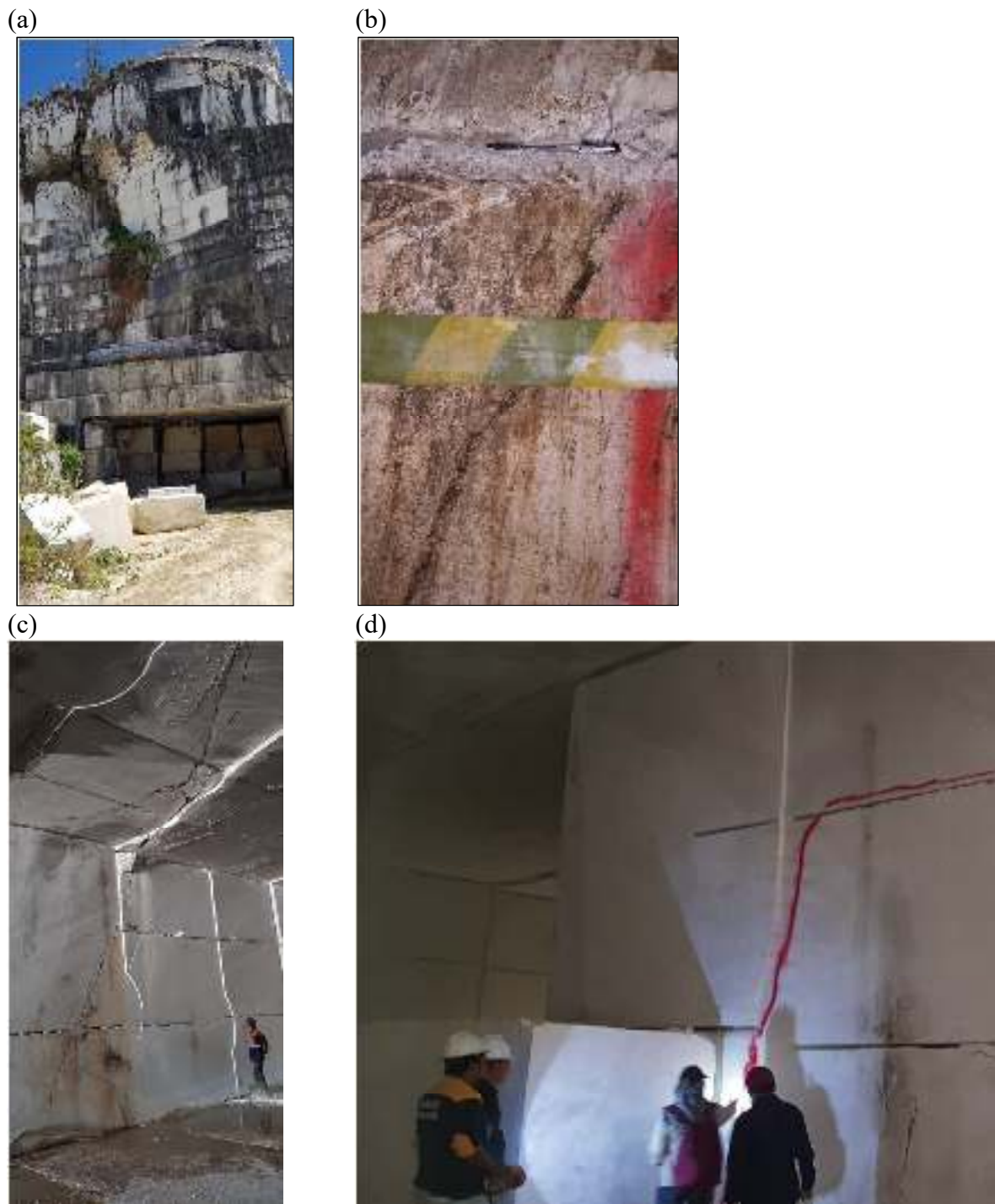
Gambar 4. Kondisi Tambang Marmer Bawah Tanah PT Gunung Marmer Raya (PT GMR); (a) Kondisi Portal Tambang Marmer Bawah Tanah dan Kekar yang Terlihat dari Luar; (b sampai d) Kondisi Kekar Utama pada Lubang Buka
