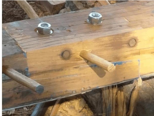
Gambar 3. Cara Penyambungan Bentuk Bibir Miring Lunas Kapal Kayu
