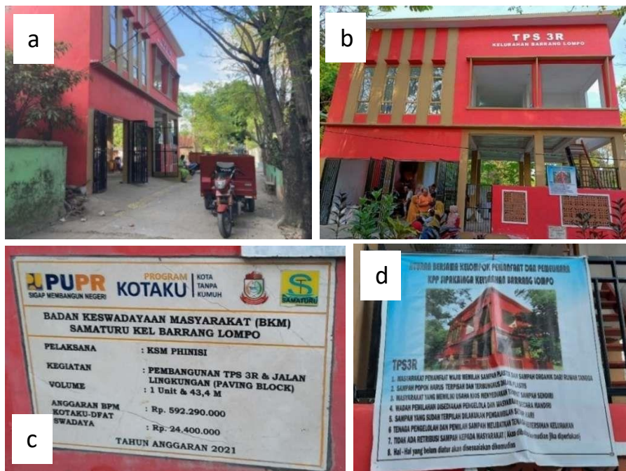
Gambar 8. Bangunan TPS Pasca Renovasi (terekam pada 31 Juli 2022, 07.41 WITA)
