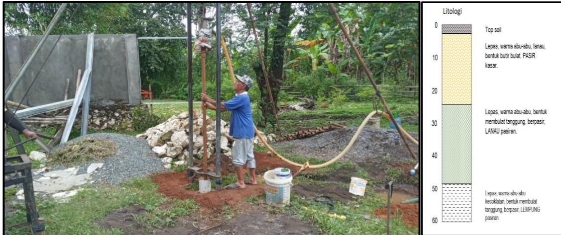
Gambar 5. Kegiatan Pengeboran Air Tanah Hingga Kedalaman 50 Meter
