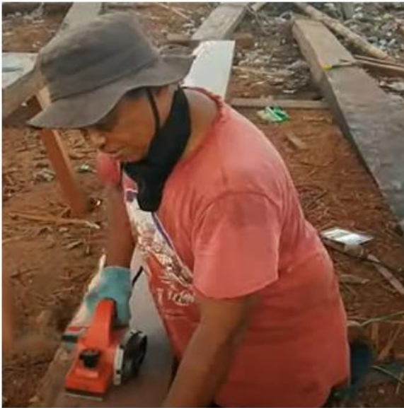
Gambar 5. Salah seorang pengrajin menggunakan peralatan listrik tanpa alat pelindung diri (APD) saat bekerja pada salah satu galangan kapal kayu ( unsafe action )
