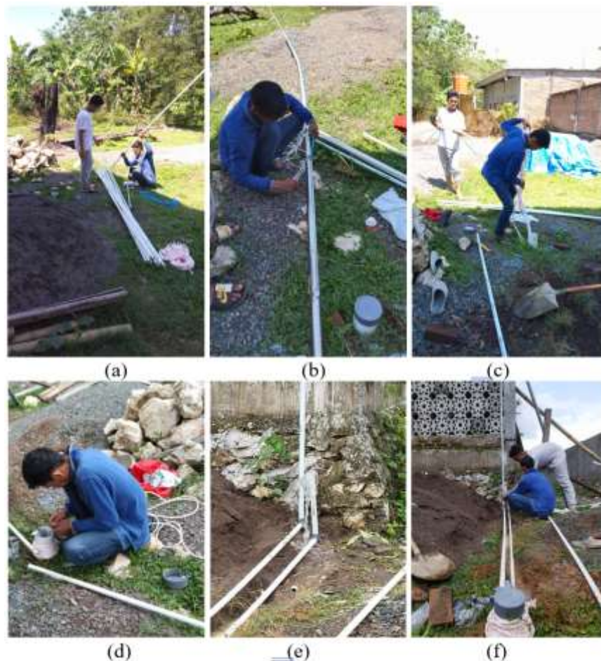
Gambar 5. Tahapan Pelaksanaan Instalasi Pompa Celup pada Sumur Produksi Air Tanah: a) Penyiapan Pompa dan Asesorisnya, b) Penyambungan Pipa dengan Pompa, c) Pemasangan Pompa pada Sumur, d) Penggantungan Pompa, e) Pengujian Fungsi Pompa, f) Penyambungan Pipa Pompa ke Reservoir.
