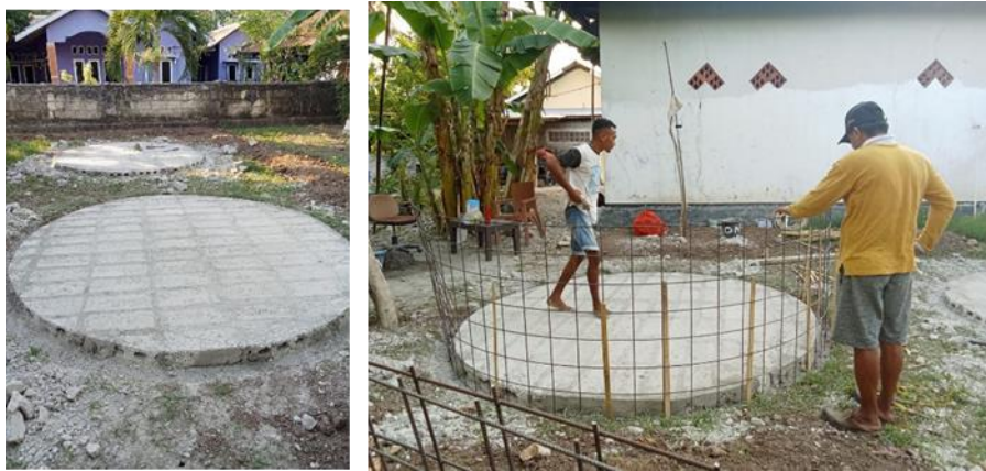
Gambar 3. Pemasangan Rangka Pendukung
