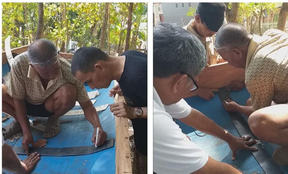
Gambar 2. Peragaan Pemasangan/Penyambungan Papan Kulit ke Rangka Baja
