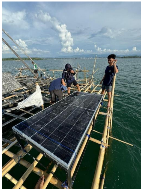
Gambar 4. Panel Surya yang Terinstal pada Bagang
