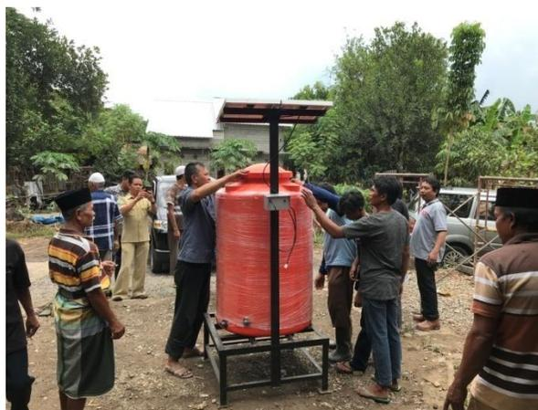
Gambar 5. Perakitan Pompa Air Tenaga Matahari
