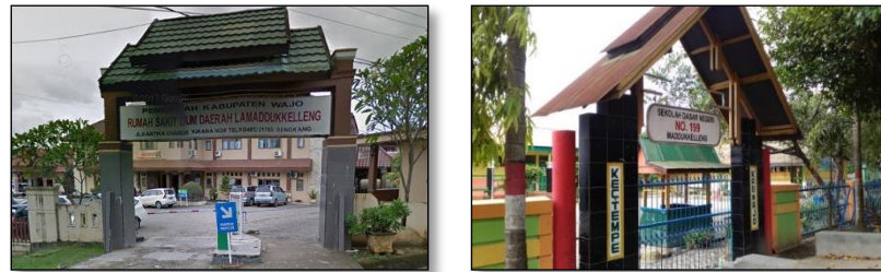
Gambar 3. Kondisi Fasilitas Sarana Prasarana
