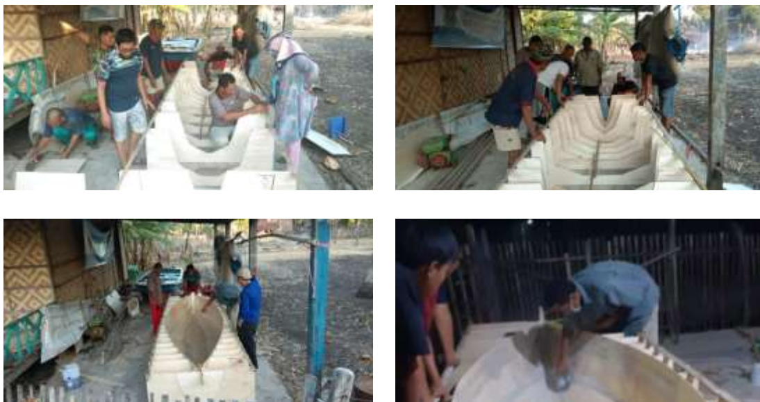
Gambar 9. Perakitan cetakan Sumber: Dokumentasi tim (2019)
