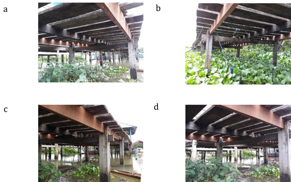
Gambar 17. Hasil Perbaikan Balok Pembujur *Trestle* yang Rusak
